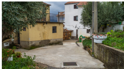
REQUALIFICAÇÃO DE ARRUAMENTOS EM MACHIALINHO
