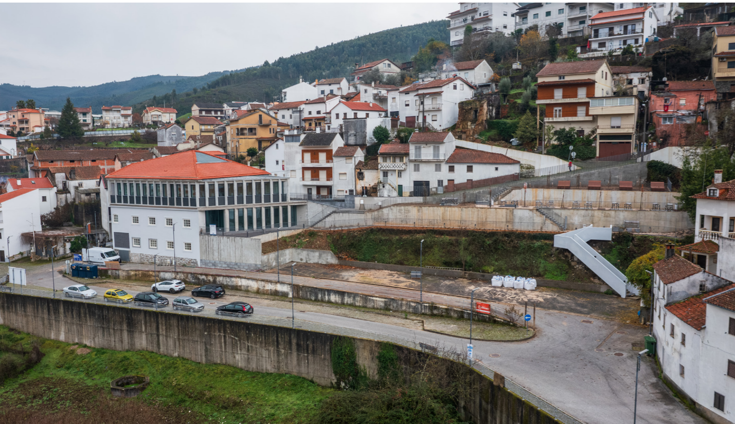
CONTINUAÇÃO DOS TRABALHOS DE REQUALIFICAÇÃO DE EDIFÍCIO - PAMPILHOSA BUSINESS CENTER
