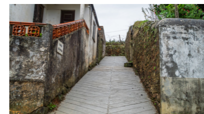
REPAVIMENTAÇÃO DE ARRUAMENTO EM AMOREIRA
