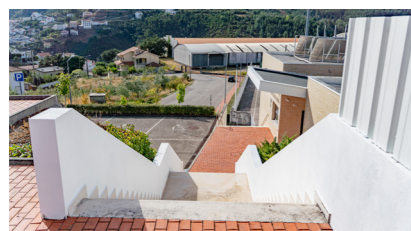
REPARAÇÕES DIVERSAS NO ESTÁDIO MUNICIPAL
