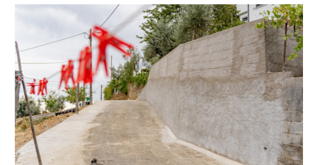
CONSTRUÇÃO DE MURO DE SUPORTE DE VIA NOS RIBEIROS
