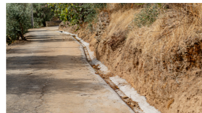
DESVIO DE ÁGUAS PLUVIAIS E CONSTRUÇÃO DE VALETA EM SOBRAL MAGRO
