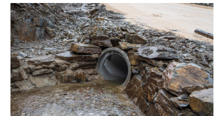
AQUEDUTOS EM COVANCA
