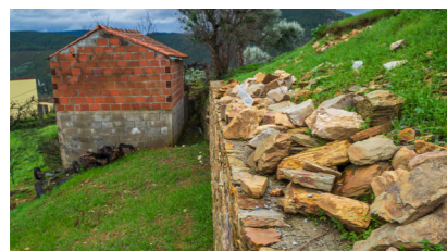
RECONSTRUÇÃO DE MURO E APLICAÇÃO DE GRELHA JUNTO AO POLIDESPORTIVO DO CARREGAL
