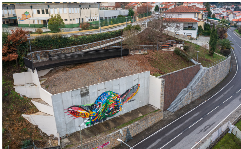
REQUALIFICAÇÃO DE MURO - ENVOLVENTE ESCOLA DE PAMPILHOSA DA SERRA
