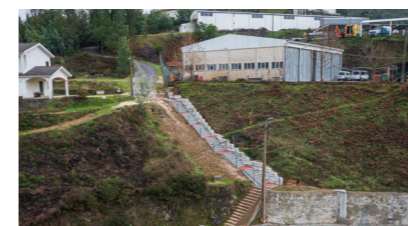
CONSTRUÇÃO DE ESCADARIA JUNTO AO ESTALEIRO MUNICIPAL
