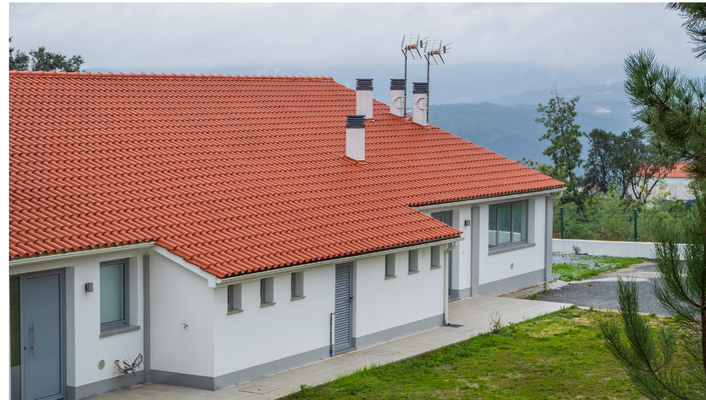
FINALIZAÇÃO DOS TRABALHOS DE REABILITAÇÃO DE EDIFÍCIO - AMOREIRA - PROGRAMA 1º DIREITO
