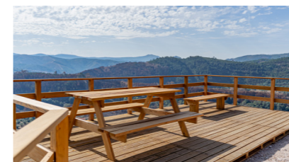
IMPLEMENTAÇÃO DO PROJETO CONDOMÍNIO DE ALDEIA - ESTEIRO
