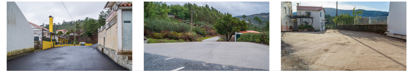
REABILITAÇÃO DE PAVIMENTOS EM ARRUAMENTOS DAS LOCALIDADES DE TRINHÃO, ALDEIA DO MEIO E SOBRAL DE BAIXO
