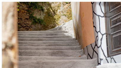
REPARAÇÃO DE ESCADA NA TRAVESSA DOS CORTINHAIS
