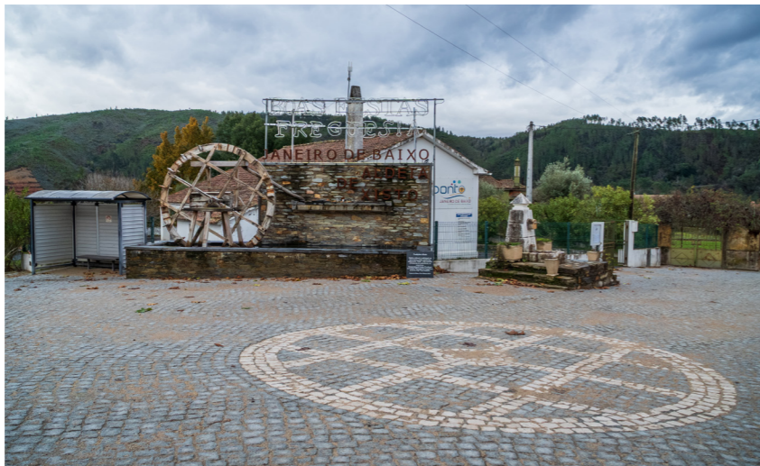
FINALIZAÇÃO DA REQUALIFICAÇÃO DE ARRUAMENTO EM JANEIRO DE BAIXO
