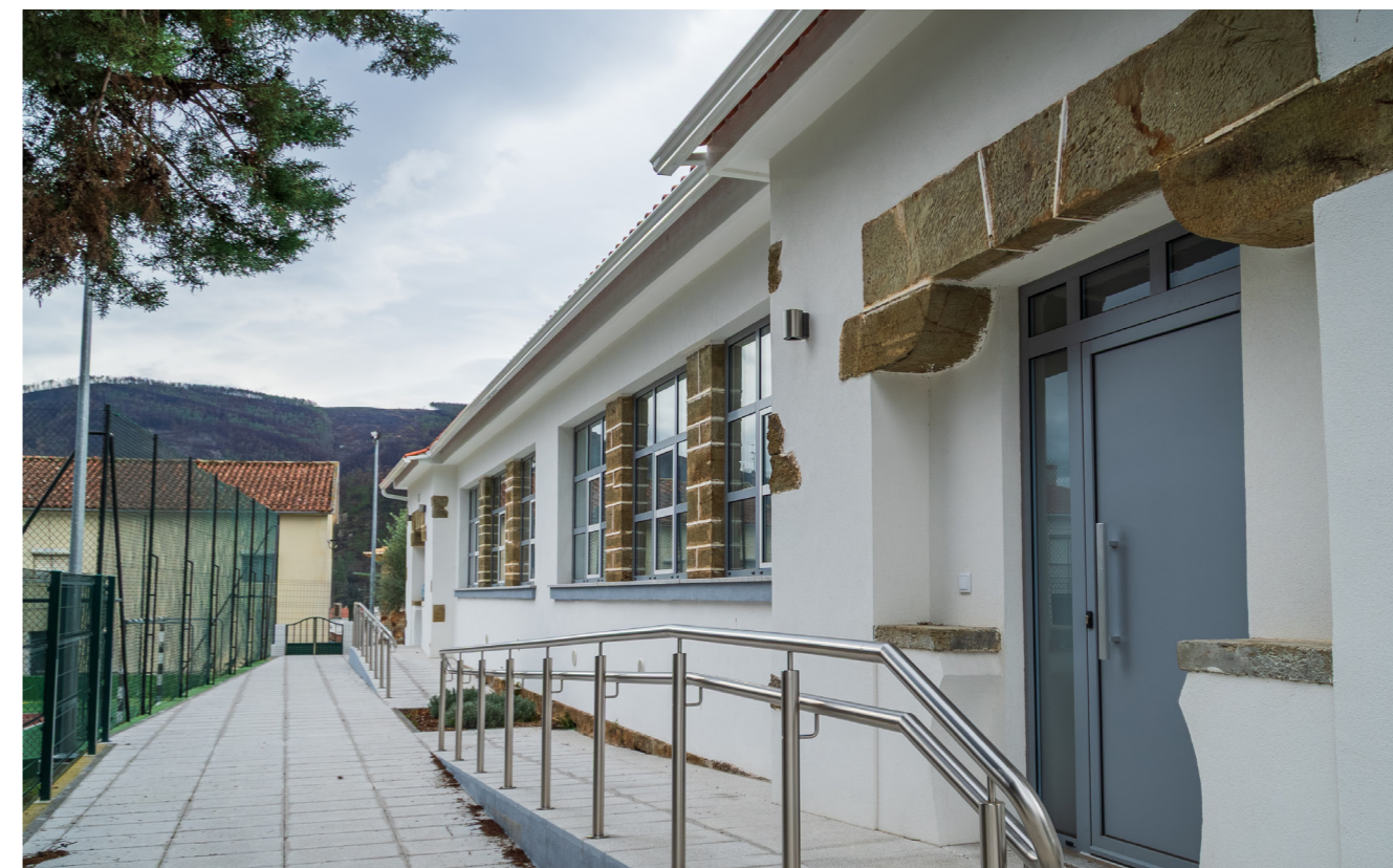
FINALIZAÇÃO DOS TRABALHOS DE REABILITAÇÃO DO EDIFÍCIO CENTRO DE ALOJAMENTO TEMPORÁRIO DE DORNELAS DO ZÊZERE
