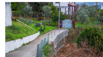
CONSTRUÇÃO DE MURO EM TRINHÃO
