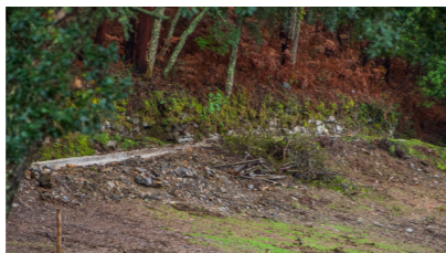
REPARAÇÃO DE LINHA DE ÁGUA EM AMOREIRA
