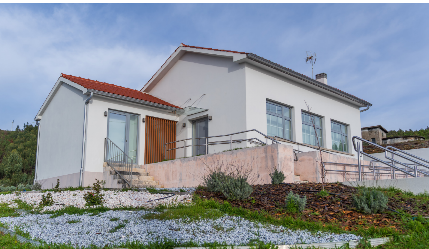
FINALIZAÇÃO DOS TRABALHOS DE REABILITAÇÃO DE EDIFÍCIO CENTRO DE ALOJAMENTO DE EMERGÊNCIA SOCIAL DE MALHADAS DA SERRA
