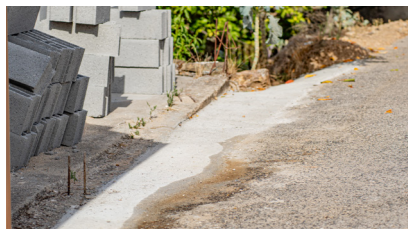
DESVIO DE ÁGUAS PLUVIAIS EM MARIA GOMES
