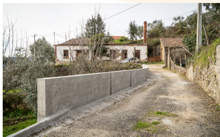
▪ Construção de muro de suporte em Amoreira;
