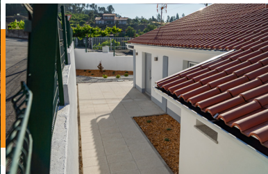
Continuação dos trabalhos de reabilitação de Edifício - Centro de Alojamento Temporário de Dornelas do Zêzere
