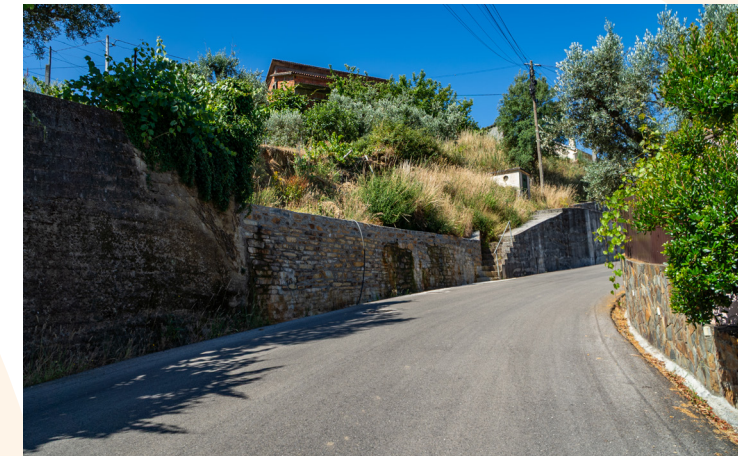
▪ Construção de muro em Porto de Vacas;
