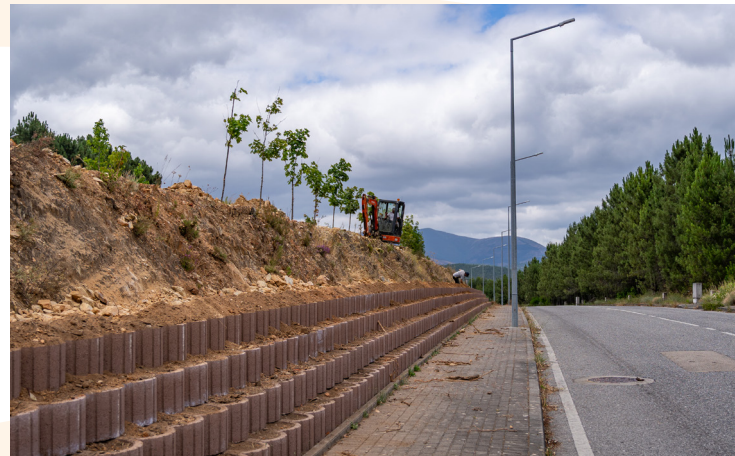
▪ Trabalhos de limpeza, requalificação de terreno e requalificação de Talude em Casal da Lapa
