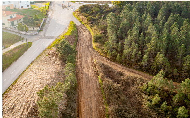
▪ Colocação de aquedutos na antiga estrada entre Portela de Unhais e Unhais-o-Velho
