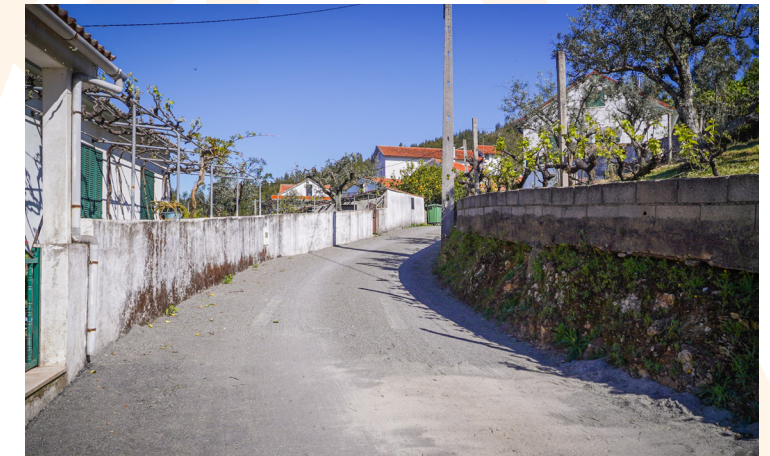
▪ Reposição de pavimento no Gavião;
