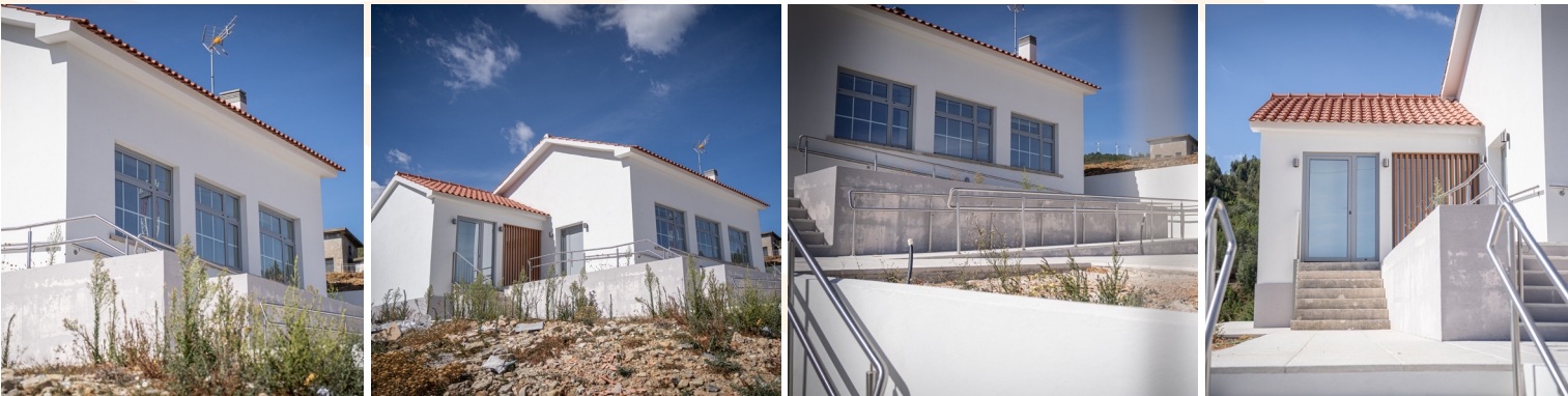
■ Reabilitação do Edifício – Centro de Emergência Social de Malhadas da Serra (antiga escola primária)
