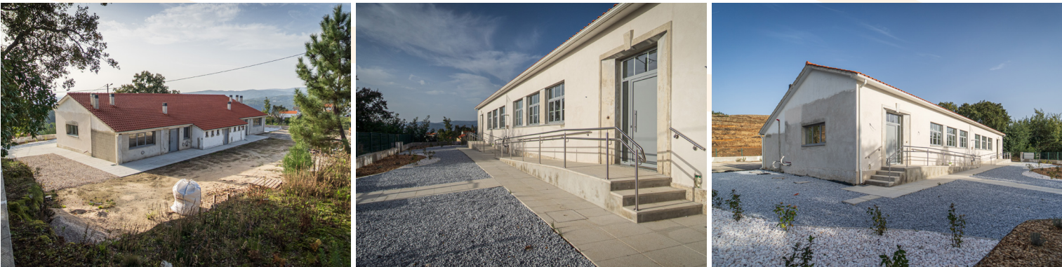
■ Reabilitação do edifício na Amoreira – Programa 1º Direito (antiga escola primária)
