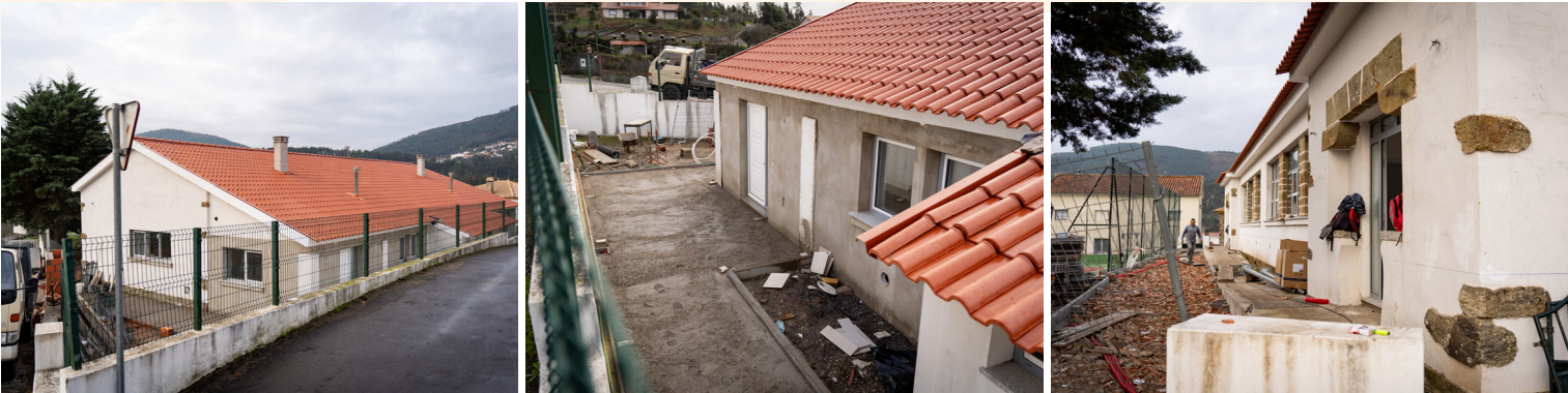
■ Reabilitação de Edifício - Centro de Alojamento Temporário de Dornelas do Zêzere (antiga escola primária)
