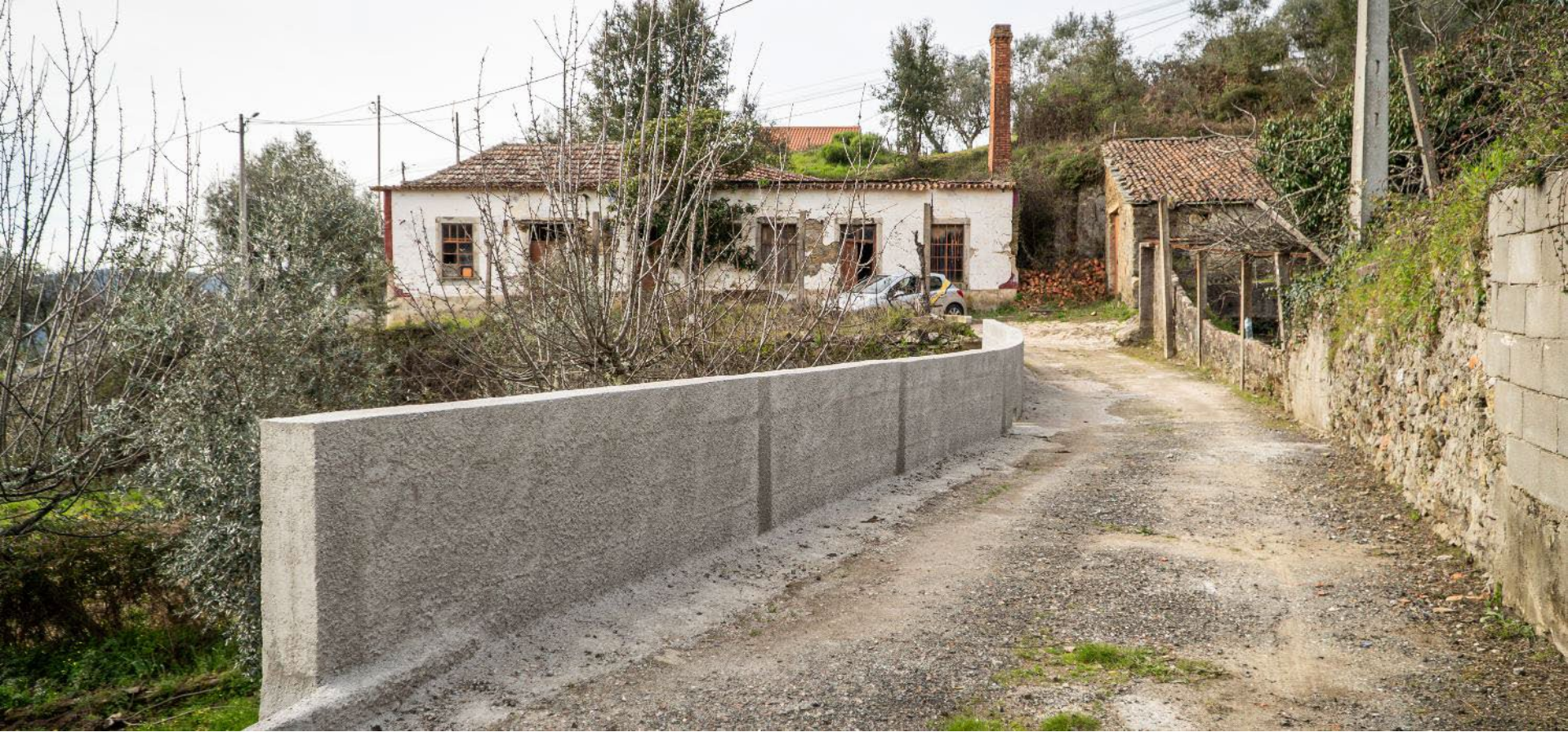
Construção de muro de suporte em Amoreira
