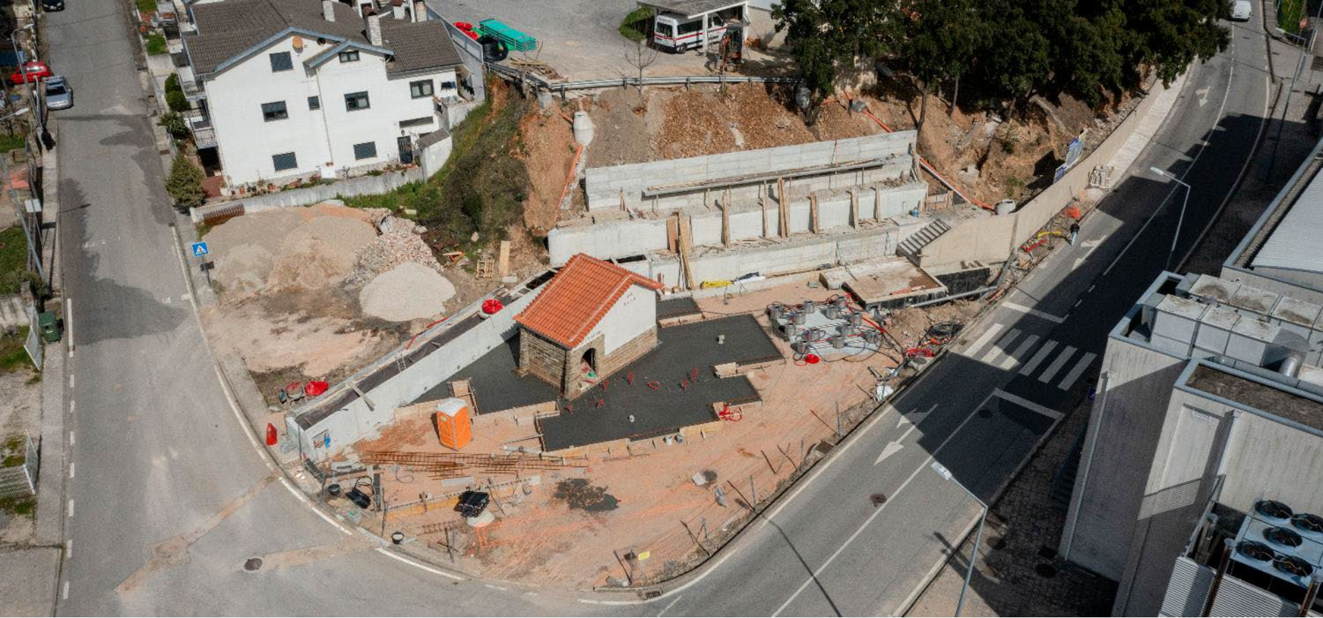
Continuação dos trabalhos de arranjo urbanístico: Entrada Oeste da Vila de Pampilhosa da Serra
