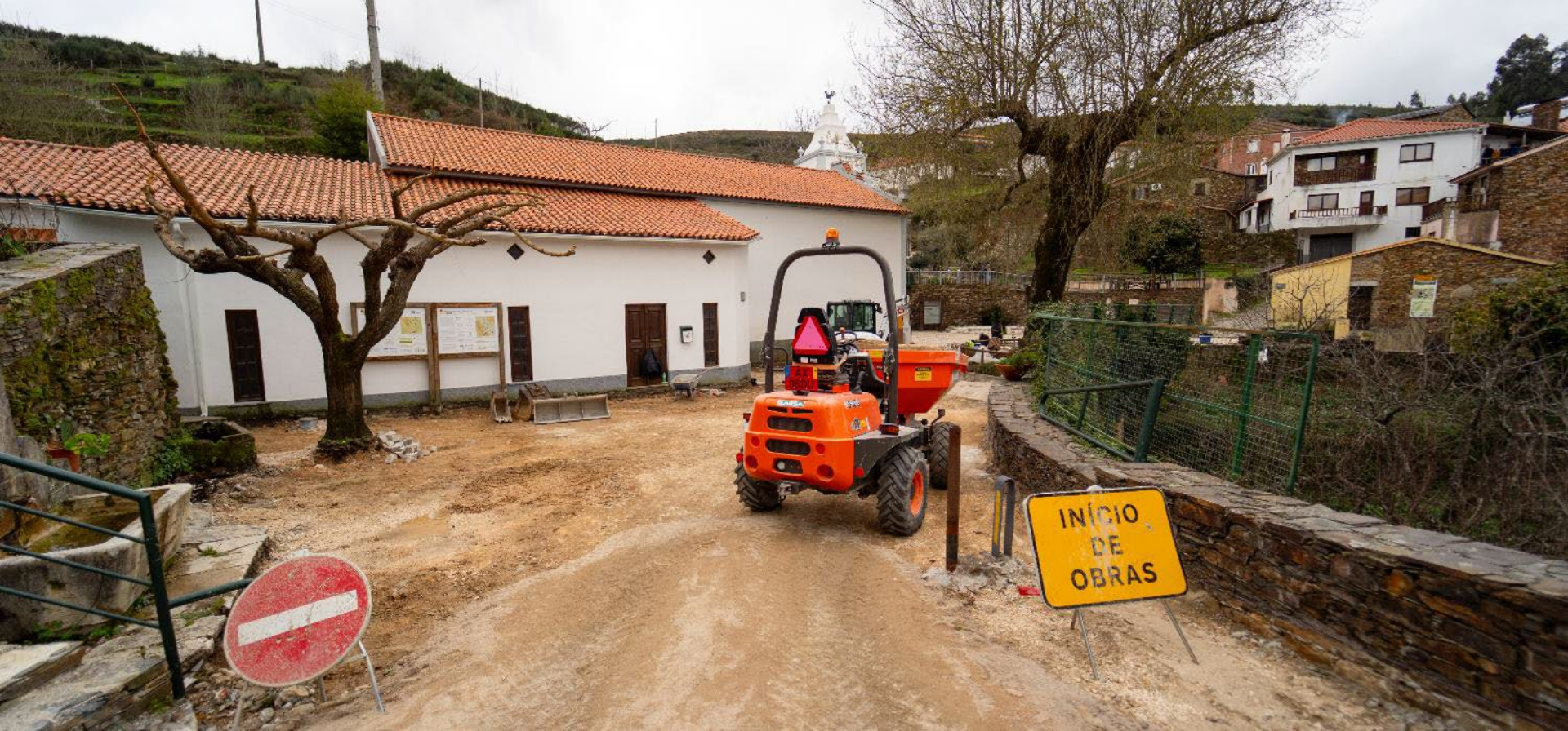
Reabilitação de pavimentos em calçada no largo da Igreja em Fajão
