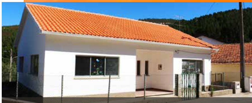
CONCLUSÃO DA REQUALIFICAÇÃO DO ANTIGO JARDIM DE INFÂNCIA DO PORTO DE VACAS
