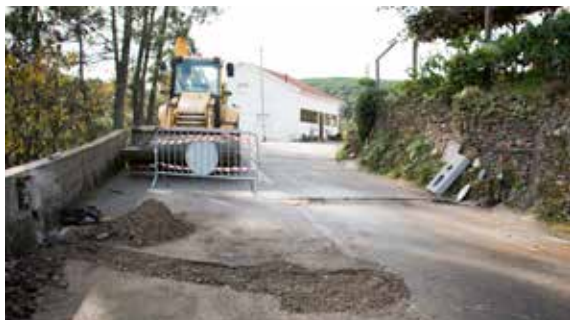
SUBSTITUIÇÃO DE RAMAIS DE ÁGUA EM MALHADA DO REI
