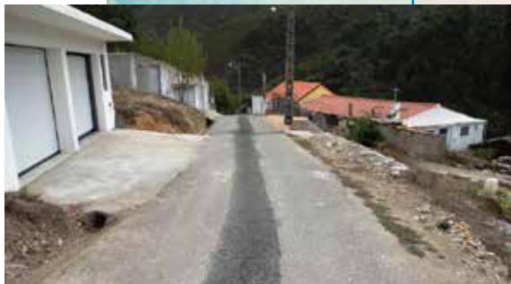
CONCLUSÃO DOS TRABALHOS DE REABILITAÇÃO DO SISTEMA DE ÁGUAS DE CEIROCO
