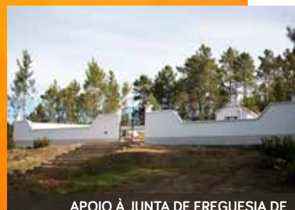
APOIO À JUNTA DE FREGUESIA DE JANEIRO DE BAIXO NA PINTURA DO CEMITÉRIO DO BREJO DE CIMA
