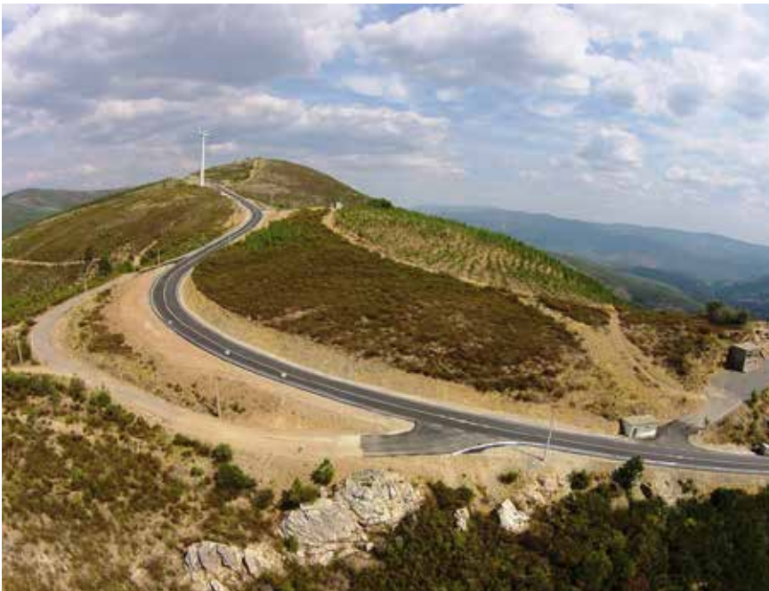
PAVIMENTAÇÃO DA ESTRADA PORTELA DE UNHAIS - ALTO DAS MINAS
