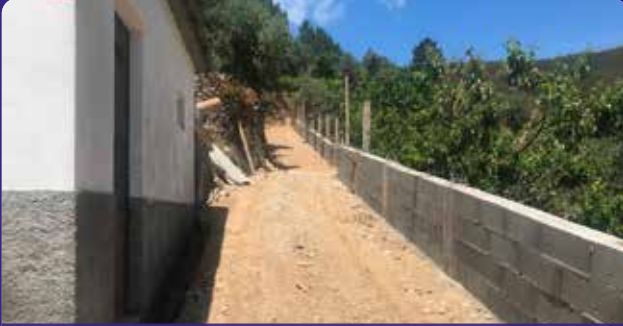
Abertura de estrada e construção de muro em Póvoa da Raposeira
