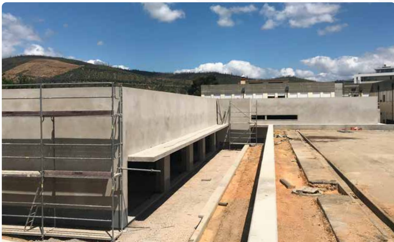
Continuação dos trabalhos de construção de novo bloco, na Escola Sede do Agrupamento de Escolas Escalada, Pampilhosa da Serra
