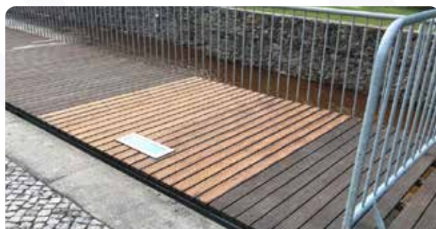
Diversas reparações na Praia Fluvial de Pampilhosa da Serra
