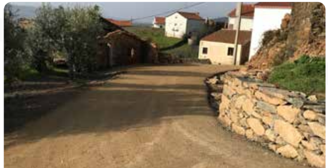
Pavimentação de arruamento em Lobatos
