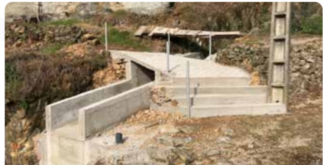
Construção de muro para desvio de águas em Maria Gomes
