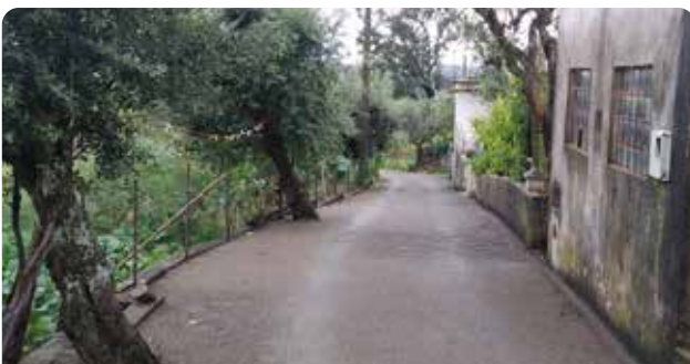
Pavimentação de arruamento em Padrões
