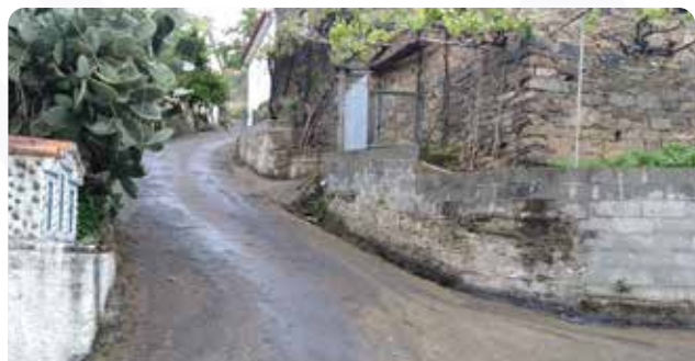
Reparação de arruamentos e colocação de selagem em Ramalheira
