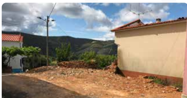
Demolição de casa em Sobral de Baixo
