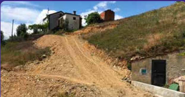
Abertura de novo arruamento em Esteiro
