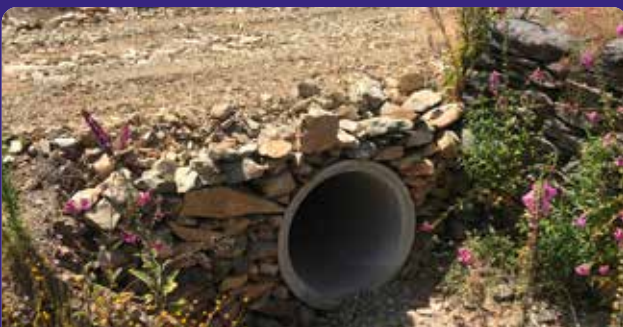
Colocação de aqueduto em estrada florestal de Aldeia Fundeira
