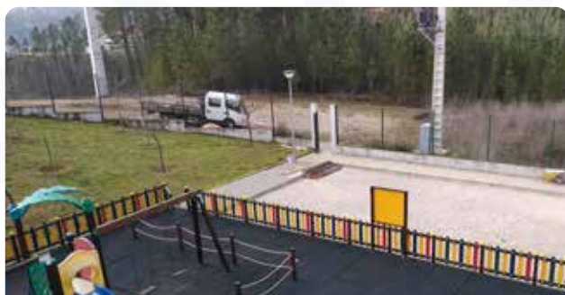
Reparações diversas no Centro Educativo de Dornelas do Zêzere
