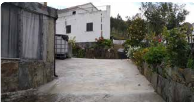
Colocação de cimento em arruamento de Malhada do Rei
