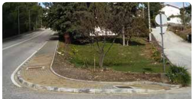
Reparação de passeio, colocação de grelha e boca de aqueduto em Casal da Lapa
