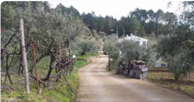
Selagem de pavimento em Machial, Aradas e estrada de Decabelos
