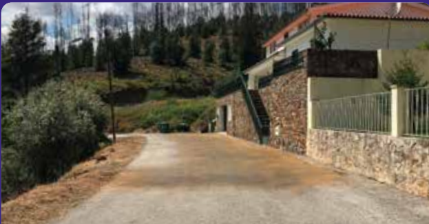
Reparação de vários arruamentos na vila de Pampilhosa da Serra
