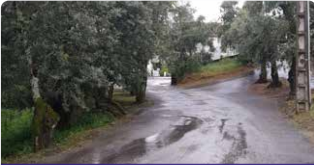
Trabalhos de requalificação de arruamentos em Amoreira
