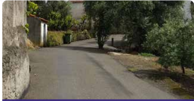
Pavimentação de diversos arruamentos em Lomba do Barco
