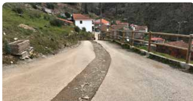
Ligação ao novo sistema de abastecimento de águas em Galhas
