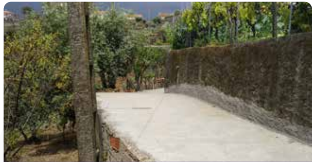
Rebaixamento e colocação de cimento em arruamento de Aldeia Fundeira
