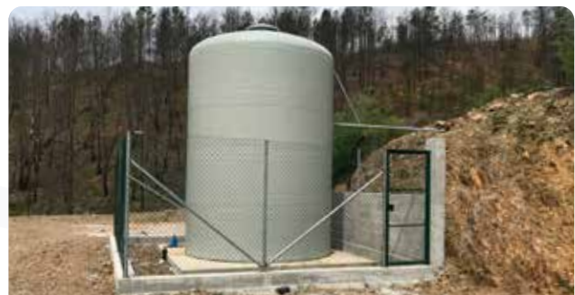
Colocação de vedação nos depósitos de água em Ponte de Fajão e Vale Pardieiro
