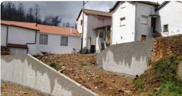
Construção de muros e requalificação de novos arruamentos em Sobral de Cima
