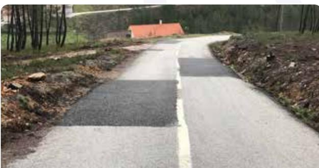
**Corte de raízes e retificação de pavimento em Aradas**
