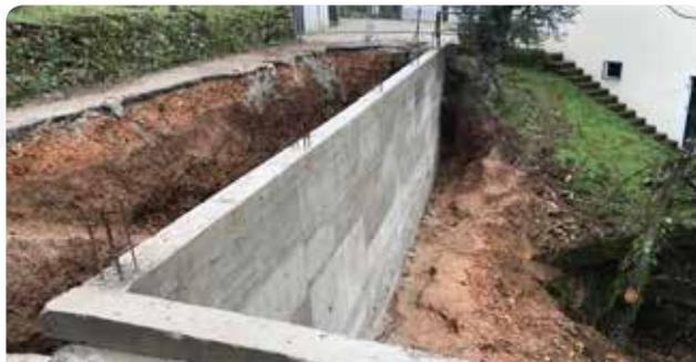
Construção de muro para suporte de via em Portas do Souto
