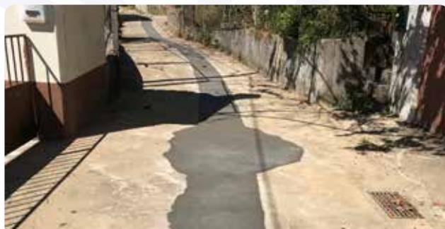
Substituição de ramal de água e reposição de cimento em Aldeia do Meio
