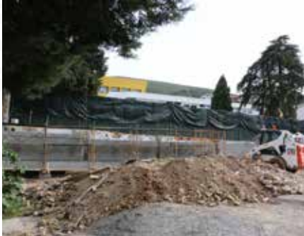
14 Construção de ossários no cemitério de Pampilhosa da Serra
