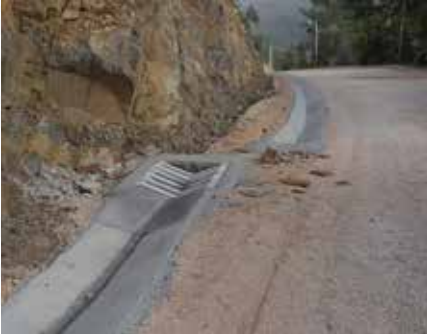
02 Finalização dos aquedutos e valetas da estrada Portela do Fojo – Vilar
