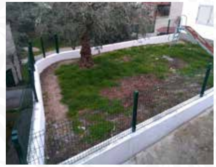
10 Colocação de vedação na antiga escola em Porto de Vacas
