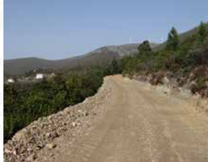
03 Retificação e correção da estrada Vale Derradeiro – Ribeiros
