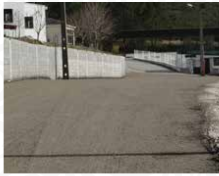
09 Retificação e alcatroamento dos acessos ao parque de merendas em Meãs
