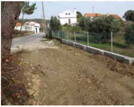
08 Construção de muro de suporte de via em Folgares
