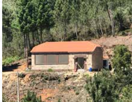
15 Apoio à coletividade de Porto da Balsa, na requalificação da escola primária
