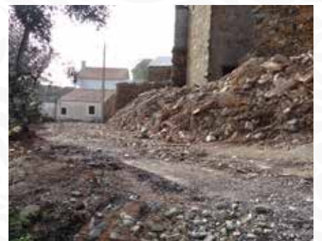
07 Abertura de novo arruamento em Lobatos
