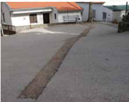
02 Finalização de baixadas de água em Portas do Souto
