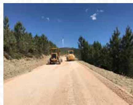
11 Colocação de tout-venant na estrada Alto Ceiroco - Camba
