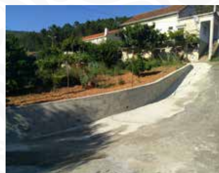
14 Construção de muro em Porto de Vacas para alargamento de arruamento
