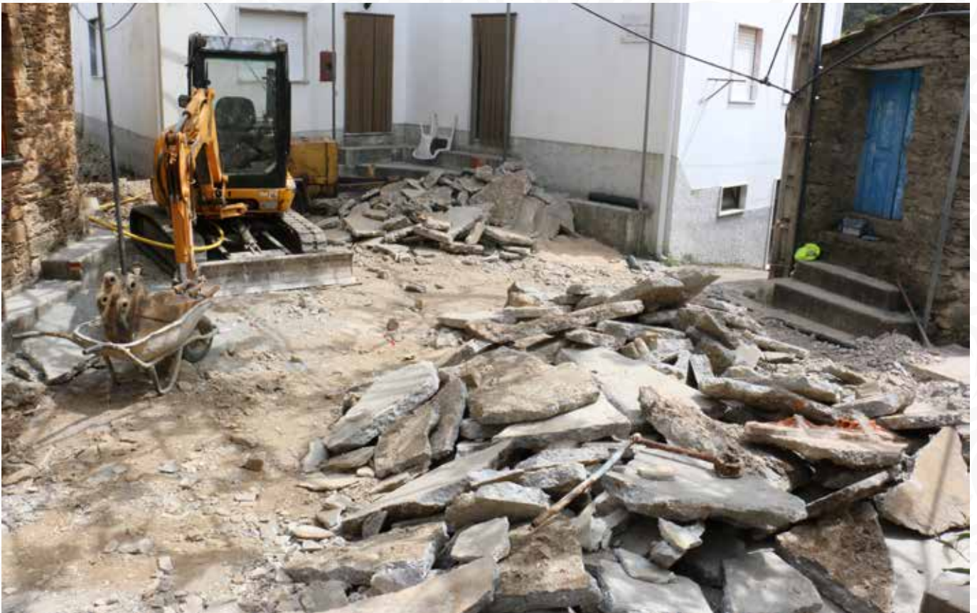
01 TRABALHOS DE SUBSTITUIÇÃO DE CONDUTAS DE ÁGUA EM PONTE DE FAJÃO
