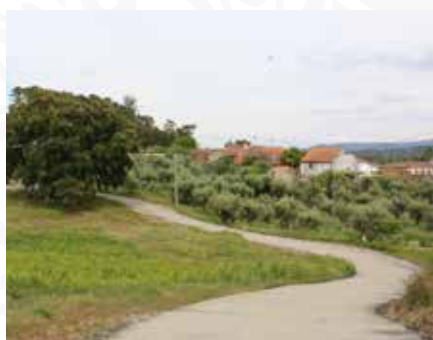
09 Pavimentação de arruamento em Padrões
