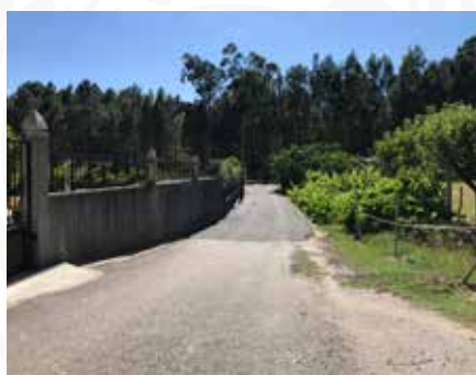
12 Repavimentação de arruamentos em Maxial e na estrada Maxial - Aldeia de S. Francisco
