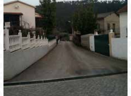
04 Colocação de novo aqueduto para águas pluviais em Janeiro de Baixo
