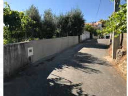
16 Reconstrução de muro em Gavião de Cima
