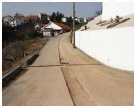
03 Substituição de ramal em Dornelas do Zêzere, Cabril e Signo Samo
