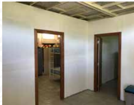
18 Reparações diversas na telescola de Unhais-o-Velho, para instalação provisória da Secção dos Bombeiros Voluntários de Pampilhosa da Serra
