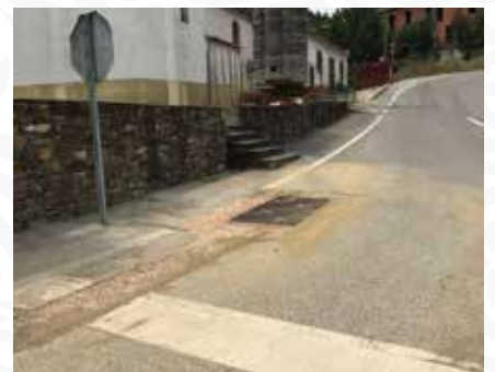
07 Ligação definitiva entre sistema de águas da Amoreira, à conduta do Vilar e à conduta para Padrões e Folgares
