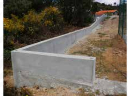
13 Construção de Muro em Sobral Valado
