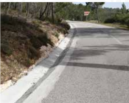
05 Colocação de Cimento em valetas de Meãs
