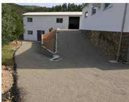
13 Pavimentação de acessos, no centro logístico da junta de freguesia de Pampilhosa da Serra
