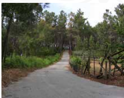
10 Reposição de pavimento em Folgares
