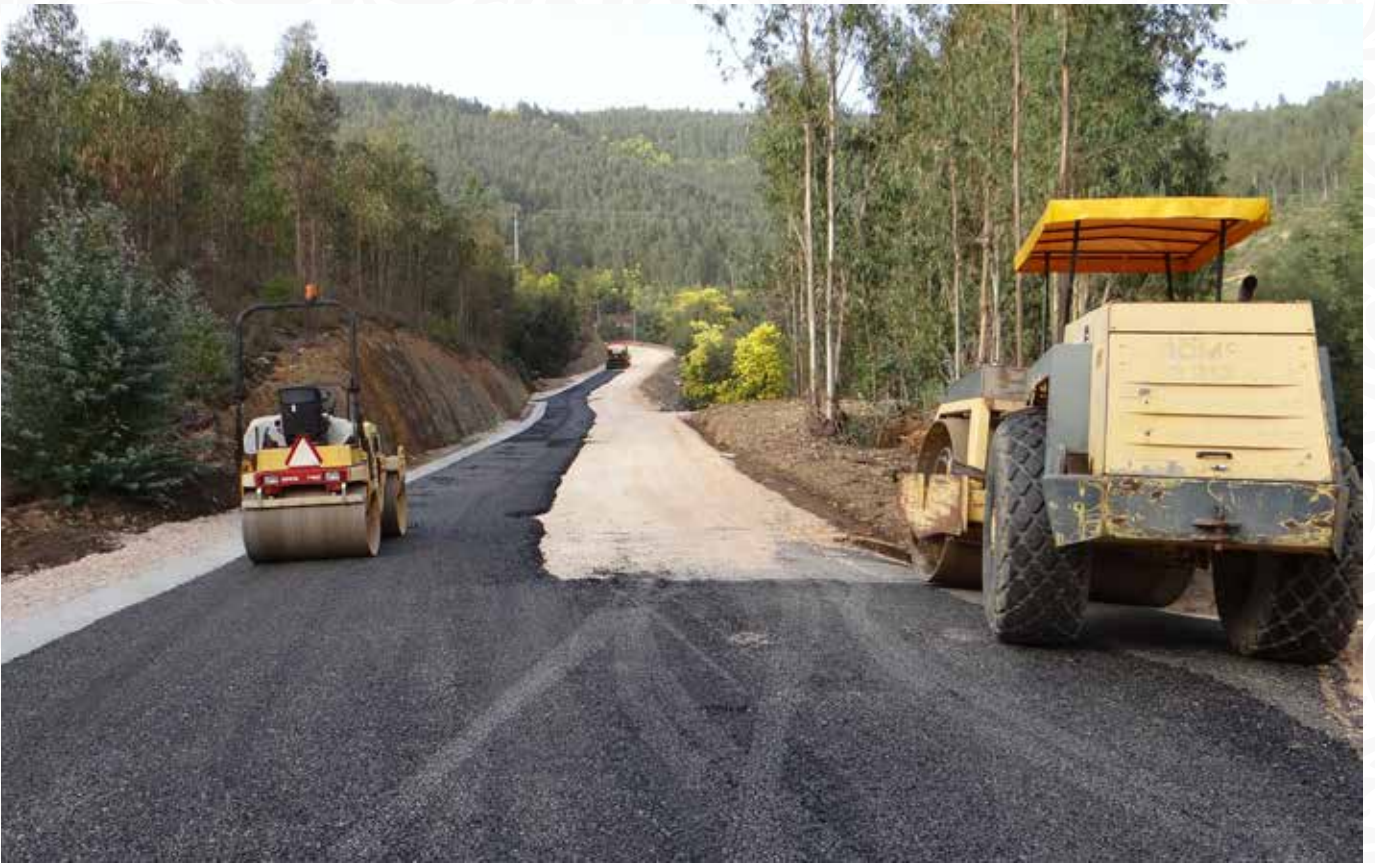
01 ALCATROAMENTO DA ESTRADA PORTELA DO FOJO - VILAR
