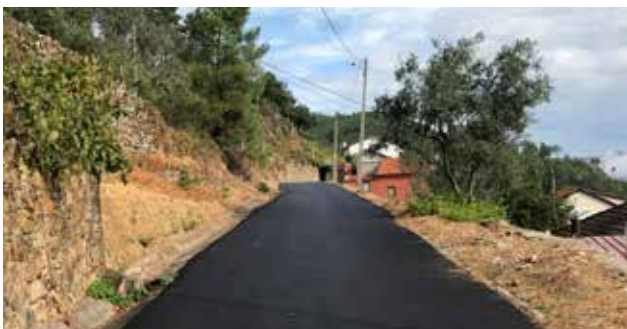
Alcatroamento de diversos arruamentos em Brejo de Cima
