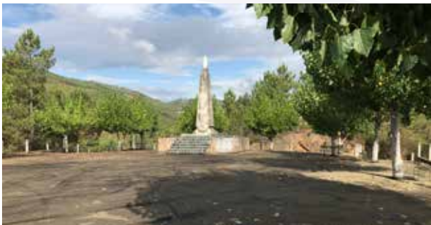
Reposição de pavimento no Cruzeiro de Dornelas do Zêzere
