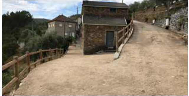
Colocação de calçada em diversos arruamentos em Gralhas
