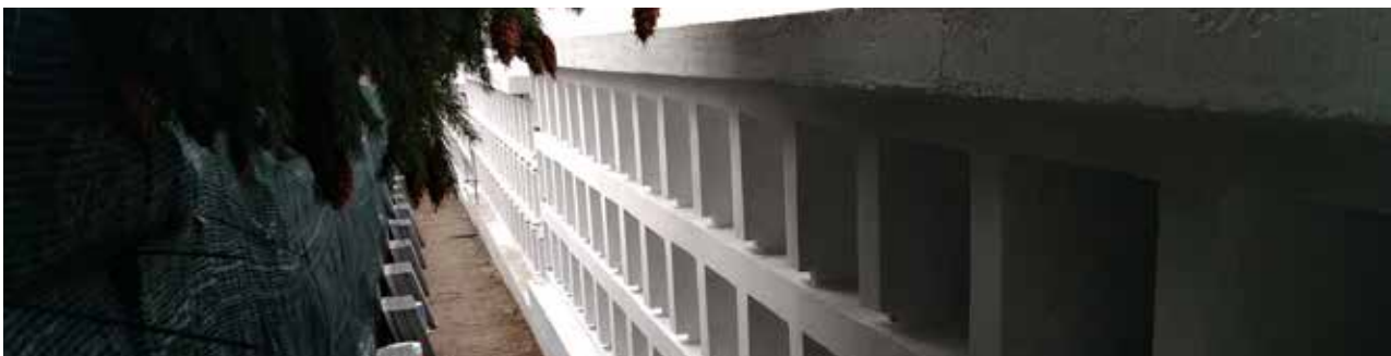
Continuação da construção de ossários no cemitério de Pampilhosa da Serra
