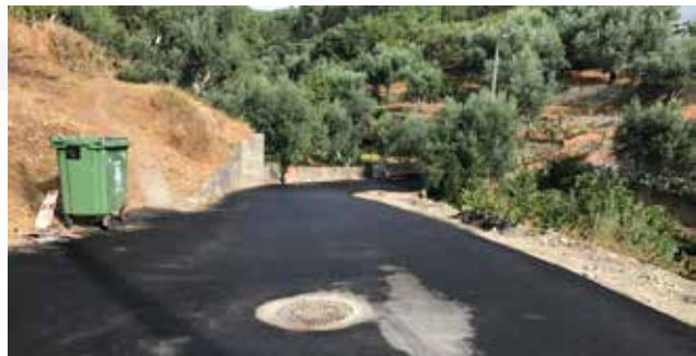
Prolongamento da rede de saneamento em Brejo de Baixo
