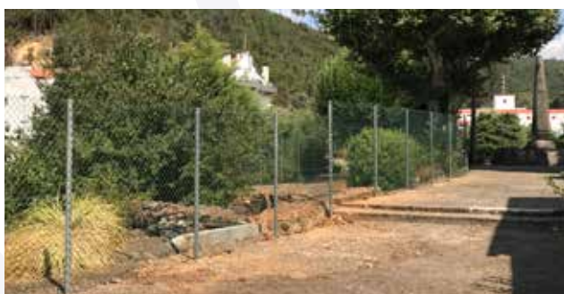
Colocação de vedação junto à Igreja de Pampilhosa da Serra
