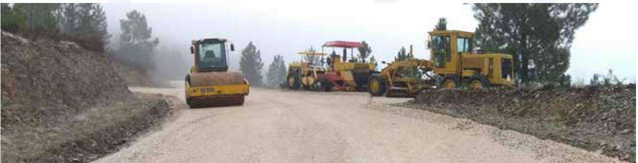
Retificação e alargamento da estrada Alto Ceiroco - Camba
