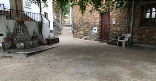
Colocação de calçada em diversos arruamentos em Ponte de Fajão
