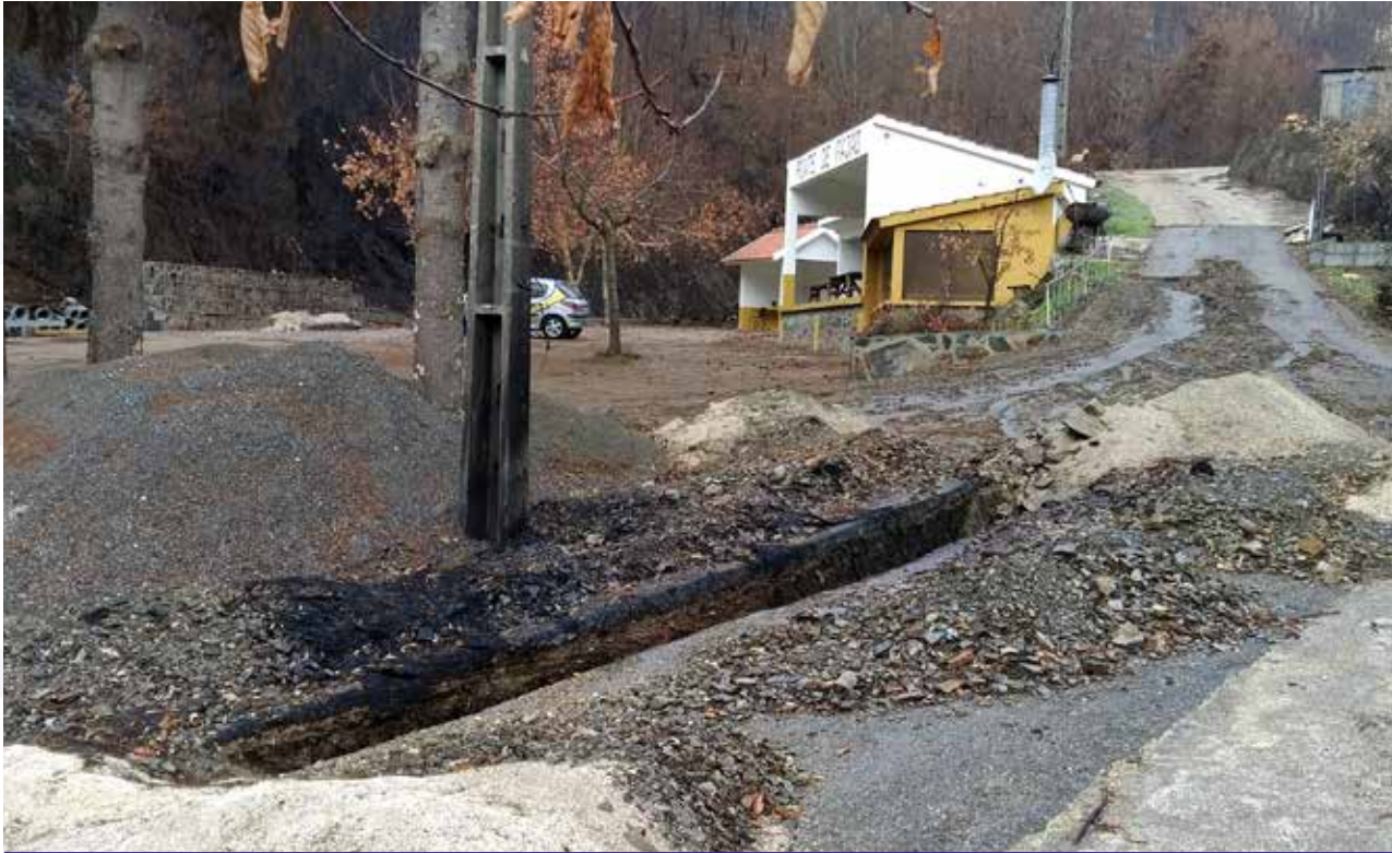
Trabalhos de substituição de condutas de água em Ponte de Fajão
