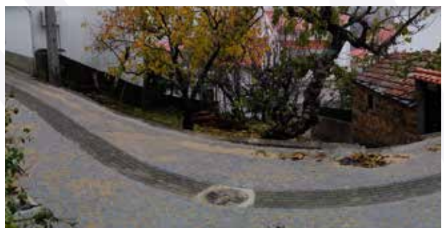
Requalificação de arruamentos em Cabril
