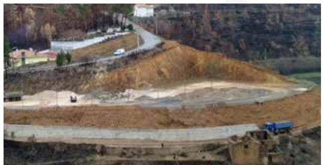
Construção de muro para alargamento de via em Pampilhosa da Serra
