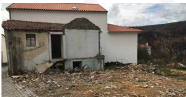
Demolição de casa em Malhadas da Serra para futura construção de Casa de Convívio
