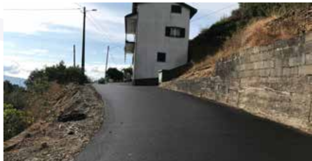
Alcatroamento de diversos arruamentos em Brejo de Baixo
