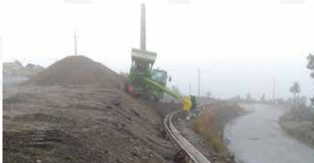
Remodelação da central de alcatrão do Município – Portela de Unhais
