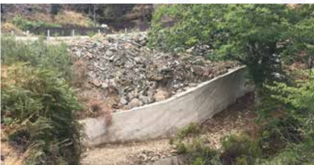
Reposição de talude de suporte de estrada em Pessegueiro
