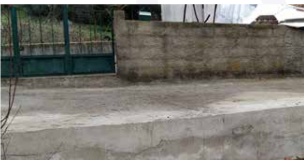
Construção de muro de suporte em Pescaneco Fundeiro
