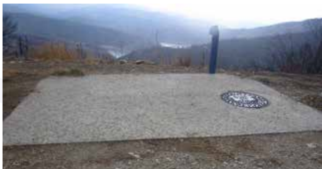
Ligação provisória do sistema de águas do Trinhão à rede de distribuição em Alta (EPAL)
