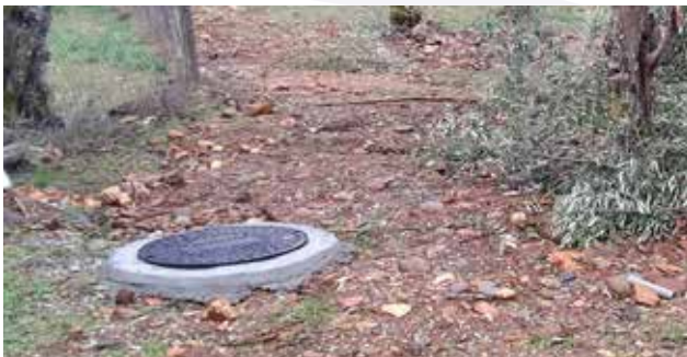
Prolongamento da rede de saneamento Janeiro de Baixo
