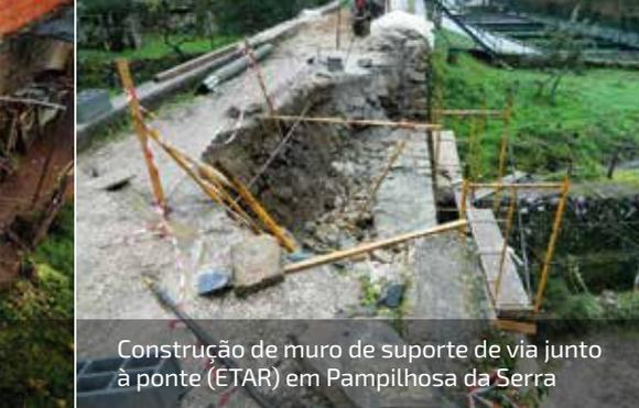
Construção de muro de suporte de via junto à ponte (ETAR) em Pampilhosa da Serra
