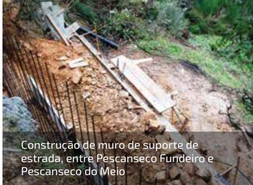
Construção de muro de suporte de estrada, entre Pescaneco Fundeiro e Pescaneco do Meio
